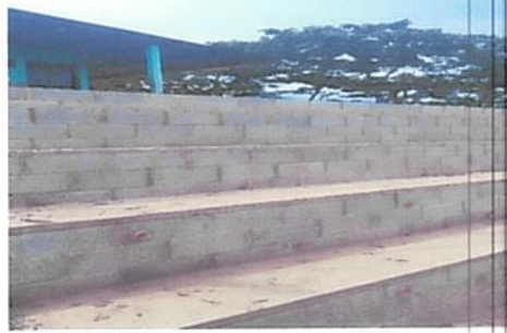
Foto 6: Finalización construcción muro de contención.
