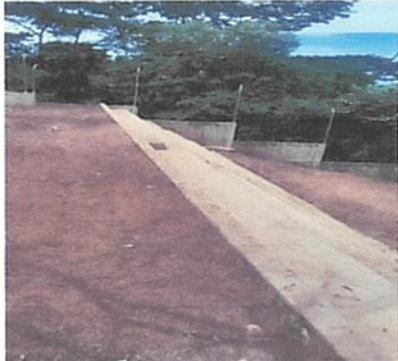
Foto 1: Finalización levantado de paredes.
