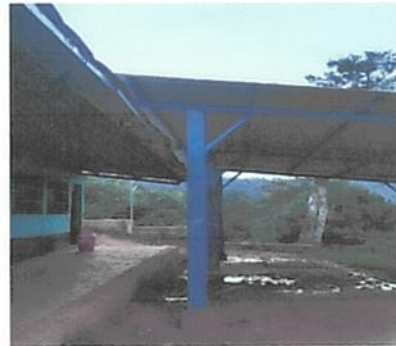
Foto 2: Finalización construcción de paredes.
