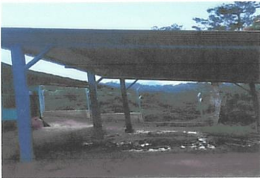
Foto 5: Finalización construcción de galera.
