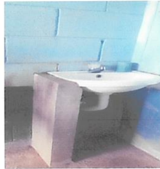
Foto 4: Finalización instalación de lavamanos.
